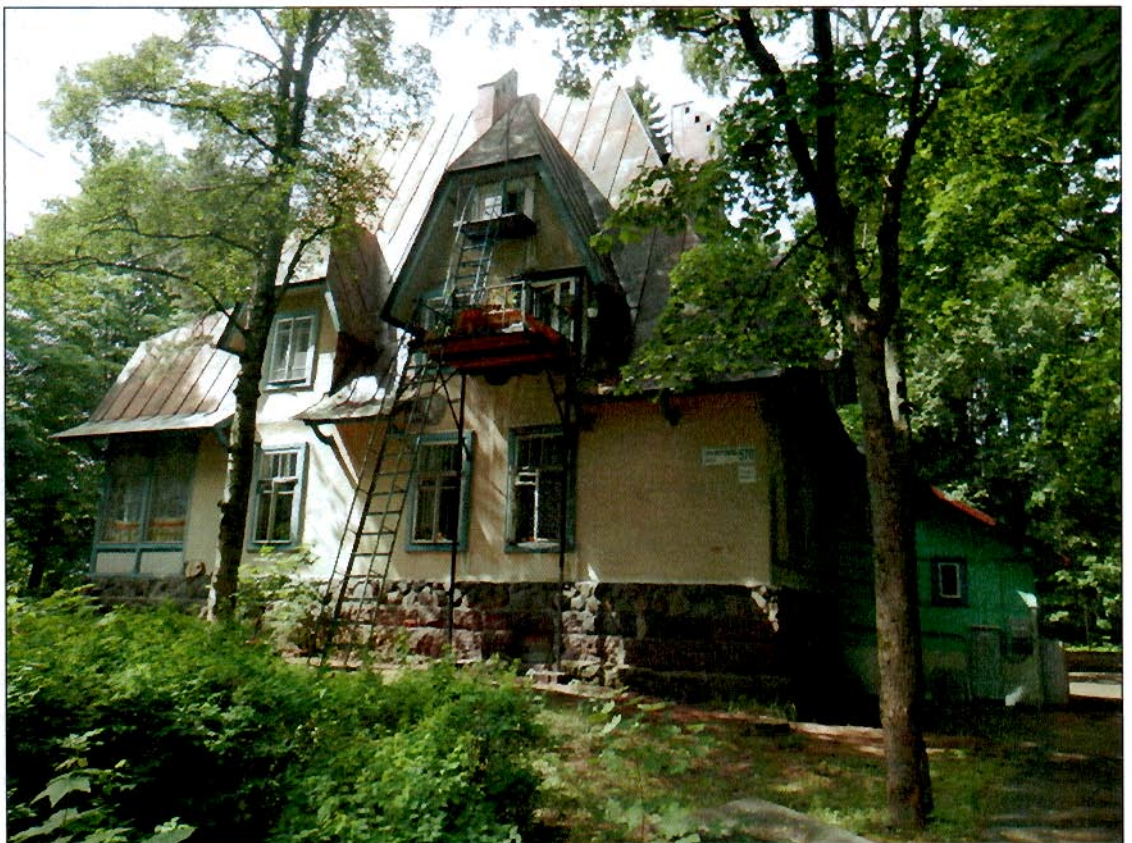
1. Общий вид с северо-востока.
