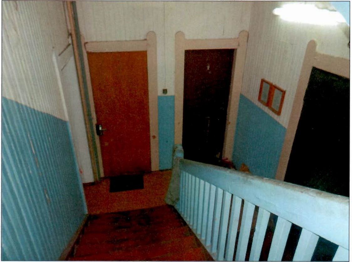
6. Интерьер. Фрагмент лестничного пространства.
