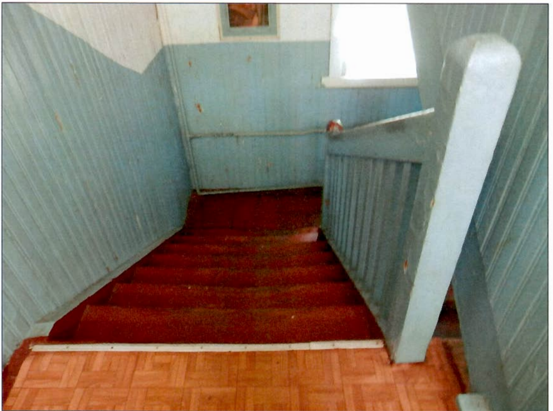
7. Интерьер. Фрагмент лестничного пространства.
