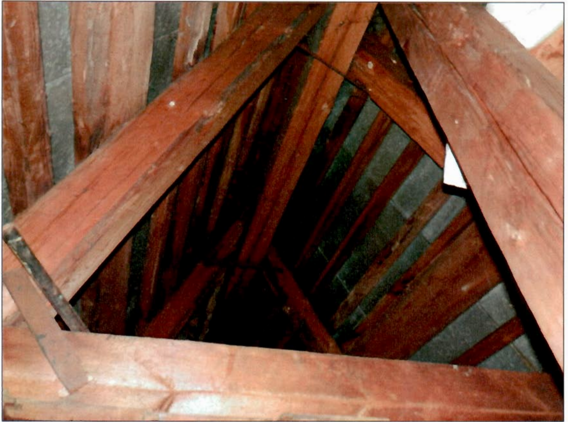
8. Стропильная система. Фрагмент.
