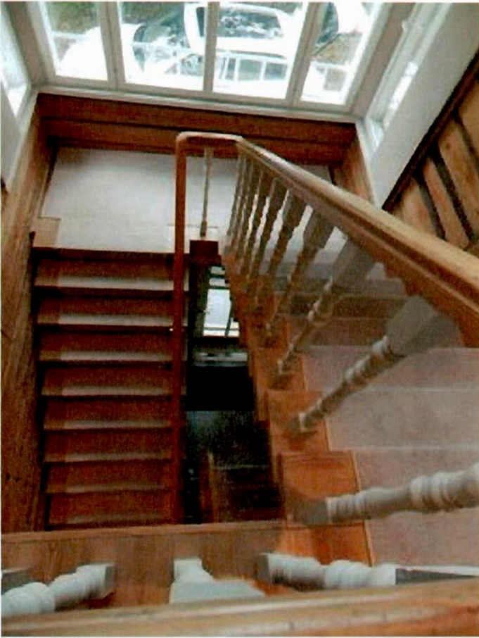
8. Лестница в северо-восточной части здания
