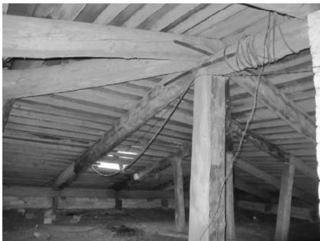
91. «Загородный дом Ф.Р. Витцеля» по адресу: Санкт-Петербург, г. Сестрорецк, Парковая ул., дом 14, литера А. Чердак. Дата съемки: 01.08.2017 г.
