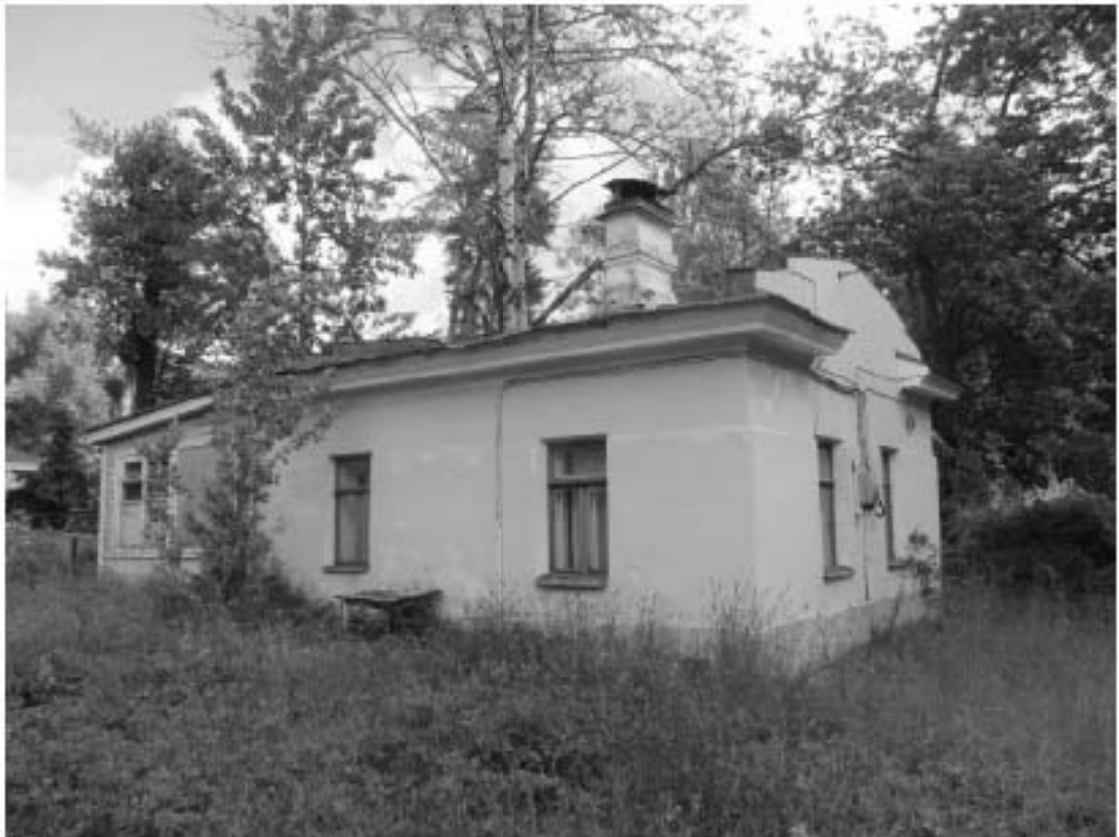
32. Здание по адресу: г. Сестрорецк, Парковая ул., дом 14, литера Н, расположенное восточнее ОКН «Загородный дом Ф.Р. Витцеля». Западный фасад. Дата съемки: 01.08.2017 г.
