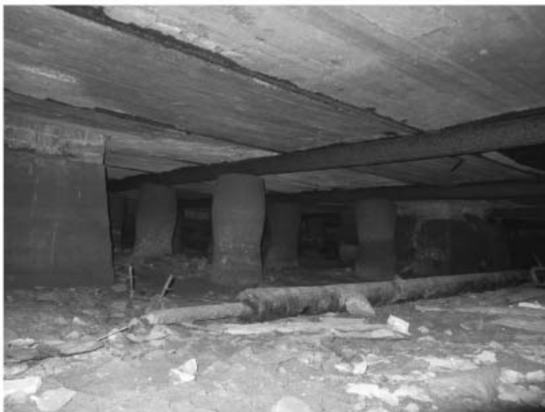
95. «Загородный дом Ф.Р. Витцеля» по адресу: Санкт-Петербург, г. Сестрорецк, Парковая ул., дом 14, литера А. Техническое подполье. Дата съемки: 01.08.2017 г.
