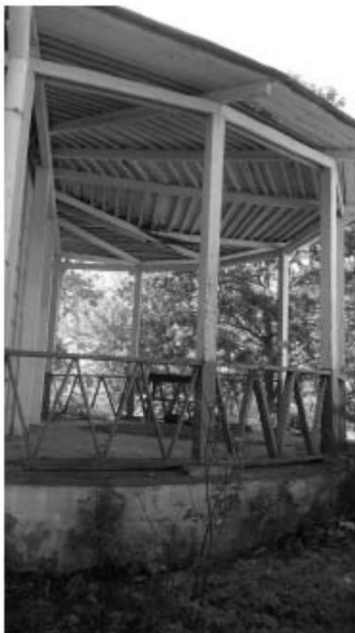
12. «Загородный дом Ф.Р. Витцеля» по адресу: Санкт-Петербург, г. Сестрорецк, Парковая ул., д. 14, литера А. Открытая терраса-полуротонда. Дата съемки: 01.08.2017 г.
