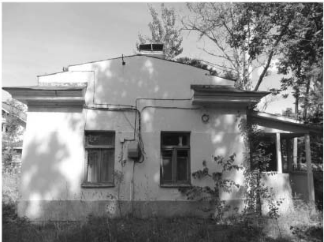
33. Здание по адресу: г. Сестрорецк, Парковая ул., дом 14, литера Н, расположенное восточнее ОКН «Загородный дом Ф.Р. Витцеля». Южный фасад. Дата съемки: 01.08.2017 г.
