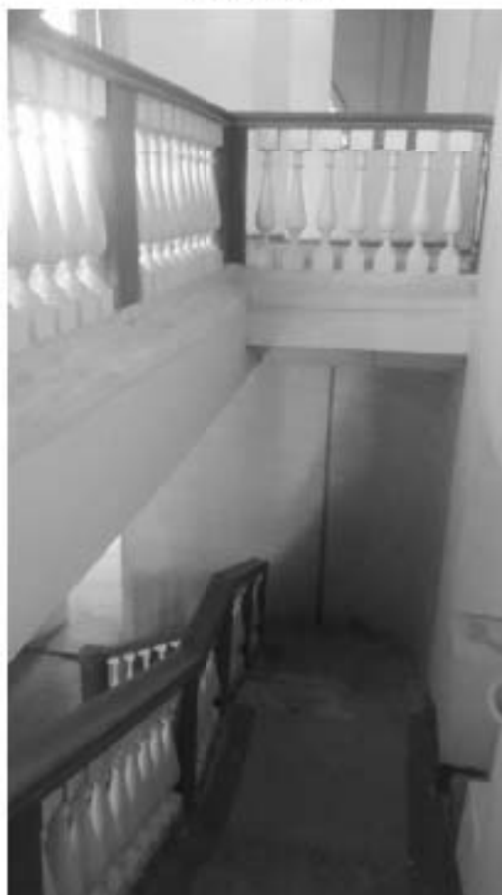
45. «Загородный дом Ф.Р. Витцеля» по адресу: Санкт-Петербург, г. Сестрорецк, Парковая ул., дом 14, литера А. 2 этаж. Помещение №28 (9,8) Лестница. Дата съемки: 01.08.2017 г.
