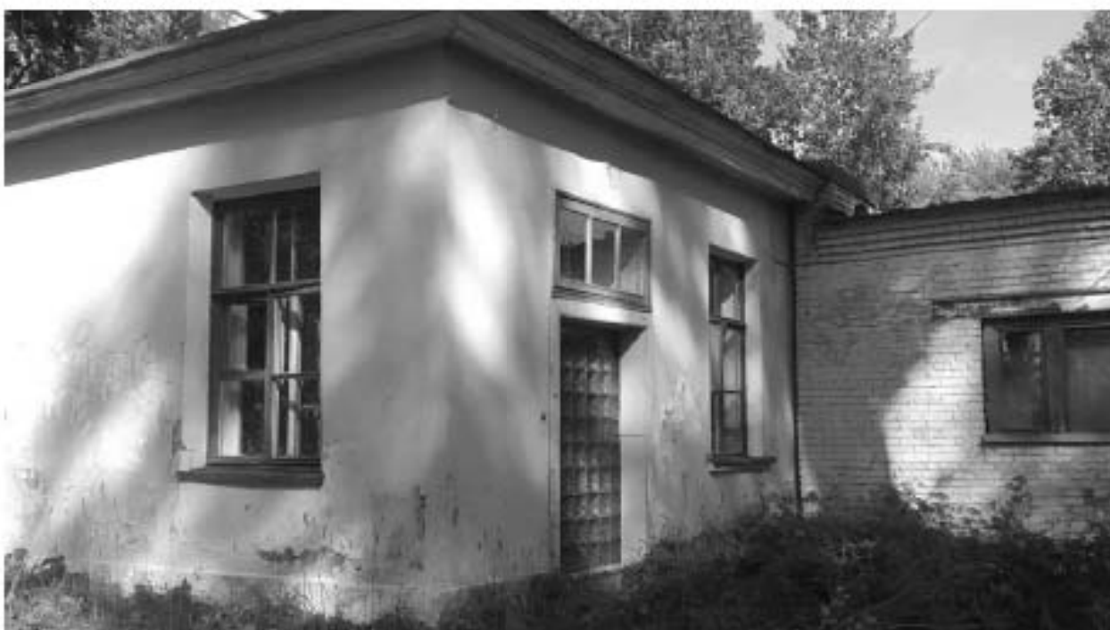
24. «Загородный дом Ф.Р. Витцеля» по адресу: Санкт-Петербург, г. Сестрорецк, Парковая ул., д. 14, литера А. Южный фасад. Дата съемки: 01.08.2017 г.
