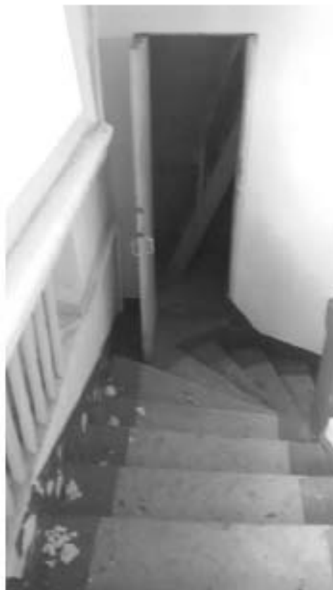
71. «Загородный дом Ф.Р. Витцеля» по адресу: Санкт-Петербург, г. Сестрорецк, Парковая ул., дом 14, литера А. 2 этаж. Помещение №28 (9,8). Лестница. Дата съемки: 01.08.2017 г.
