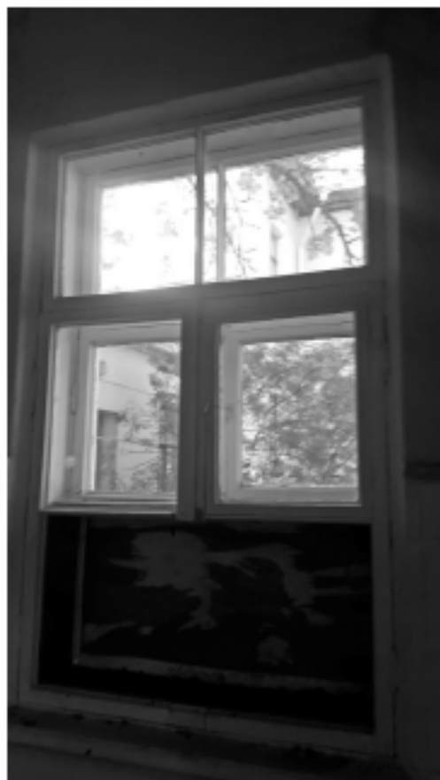
75. «Загородный дом Ф.Р. Витцеля» по адресу: Санкт-Петербург, г. Сестрорецк, Парковая ул., дом 14, литера А. Одноэтажная пристройка. Помещение №6 (13,5). Дата съемки: 01.08.2017 г.
