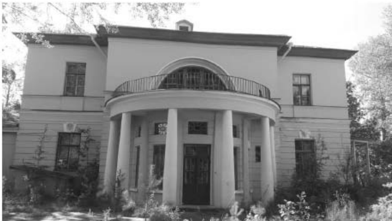
8. «Загородный дом Ф.Р. Витцеля» по адресу: Санкт-Петербург, г. Сестрорецк, Парковая ул., д. 14, литера А. Восточный фасад. Полуротонда с колоннадой, балкон в уровне 2-го этажа. Дата съемки: 01.08.2017 г.
