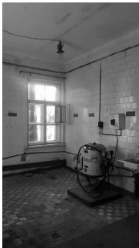
79. «Загородный дом Ф.Р. Витцеля» по адресу: Санкт-Петербург, г. Сестрорецк, Парковая ул., дом 14, литера А. Одноэтажная пристройка. Помещение №5 (33,1). Дата съемки: 01.08.2017 г.
