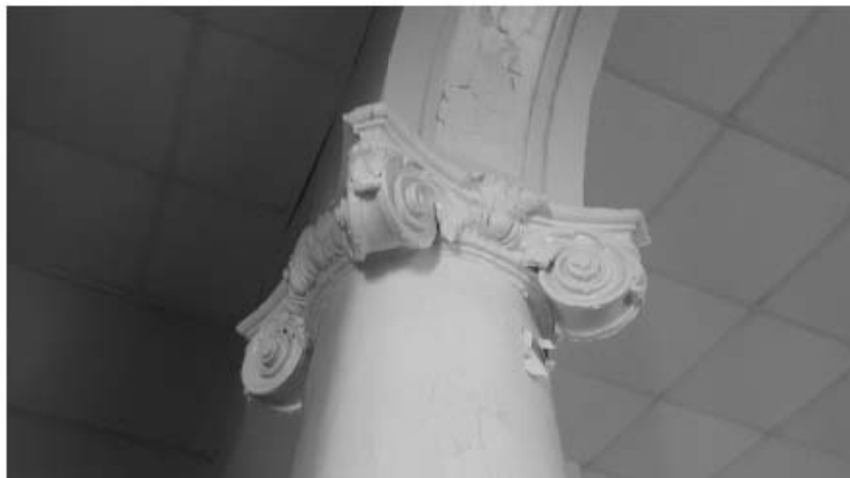
14. «Загородный дом Ф.Р. Витцеля» по адресу: Санкт-Петербург, г. Сестрорецк, Парковая ул., дом 14, литера А. 1 этаж. Помещение №5 (60,1). Капитель. Дата съемки: 01.08.2017 г.
