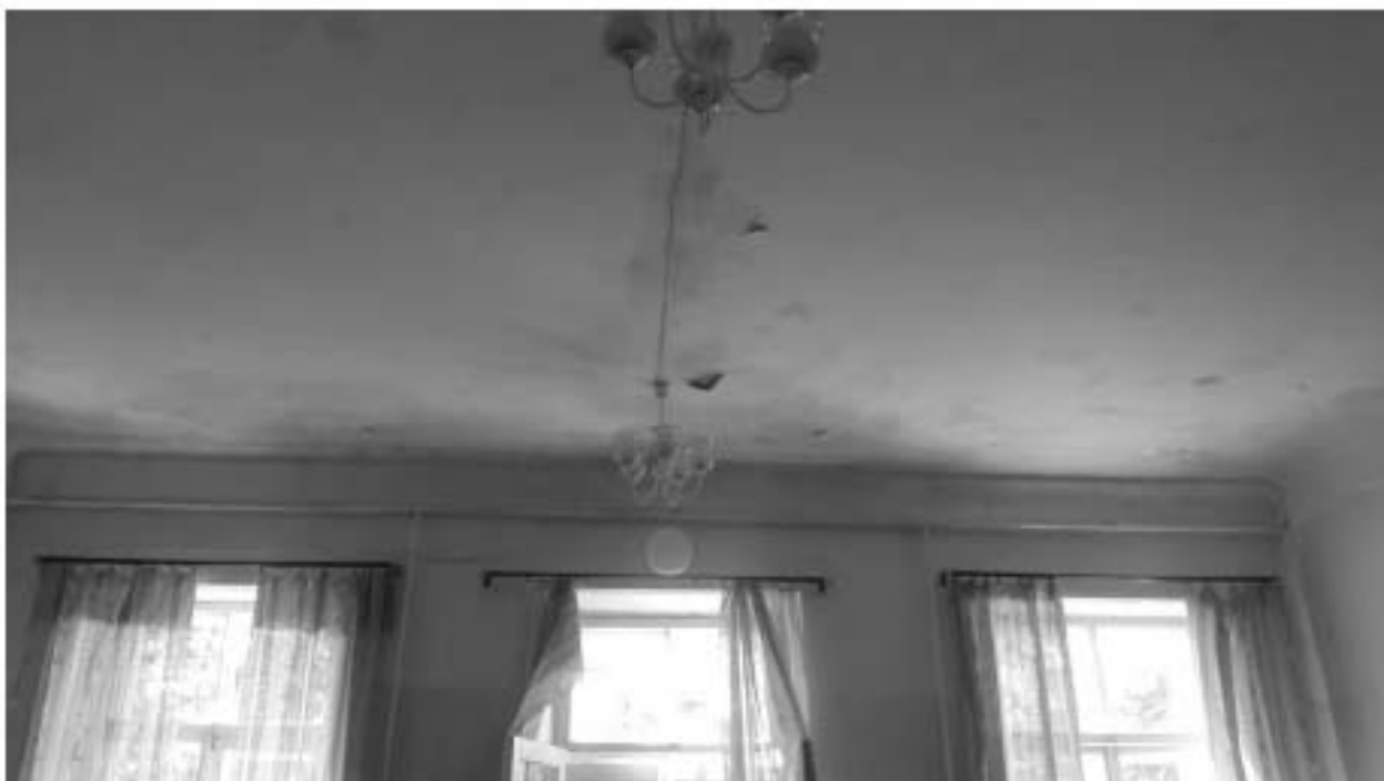
53. «Загородный дом Ф.Р. Витцеля» по адресу: Санкт-Петербург, г. Сестрорецк, Парковая ул., дом 14, литера А. 2 этаж. Помещение №21 (43,3). Дата съемки: 01.08.2017 г.
