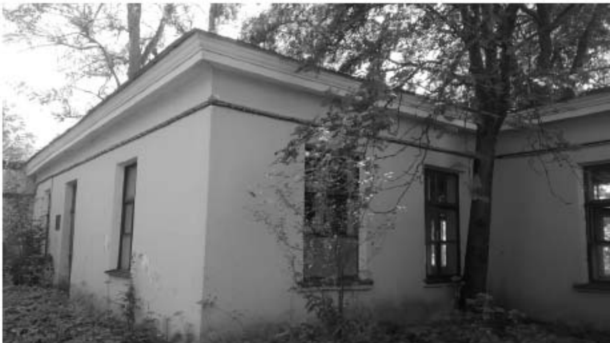
3. «Загородный дом Ф.Р. Витцеля» по адресу: Санкт-Петербург, г. Сестрорецк, Парковая ул., д. 14, литера А. Северный фасад. Дата съемки: 01.08.2017 г.
