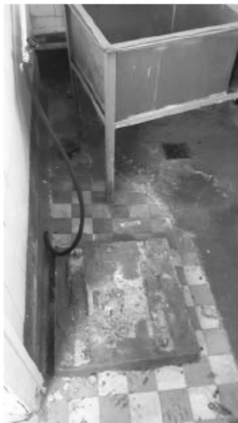
77. «Загородный дом Ф.Р. Витцеля» по адресу: Санкт-Петербург, г. Сестрорецк, Парковая ул., дом 14, литера А. Одноэтажная пристройка. Помещение №7 (6,2). Дата съемки: 01.08.2017 г.
