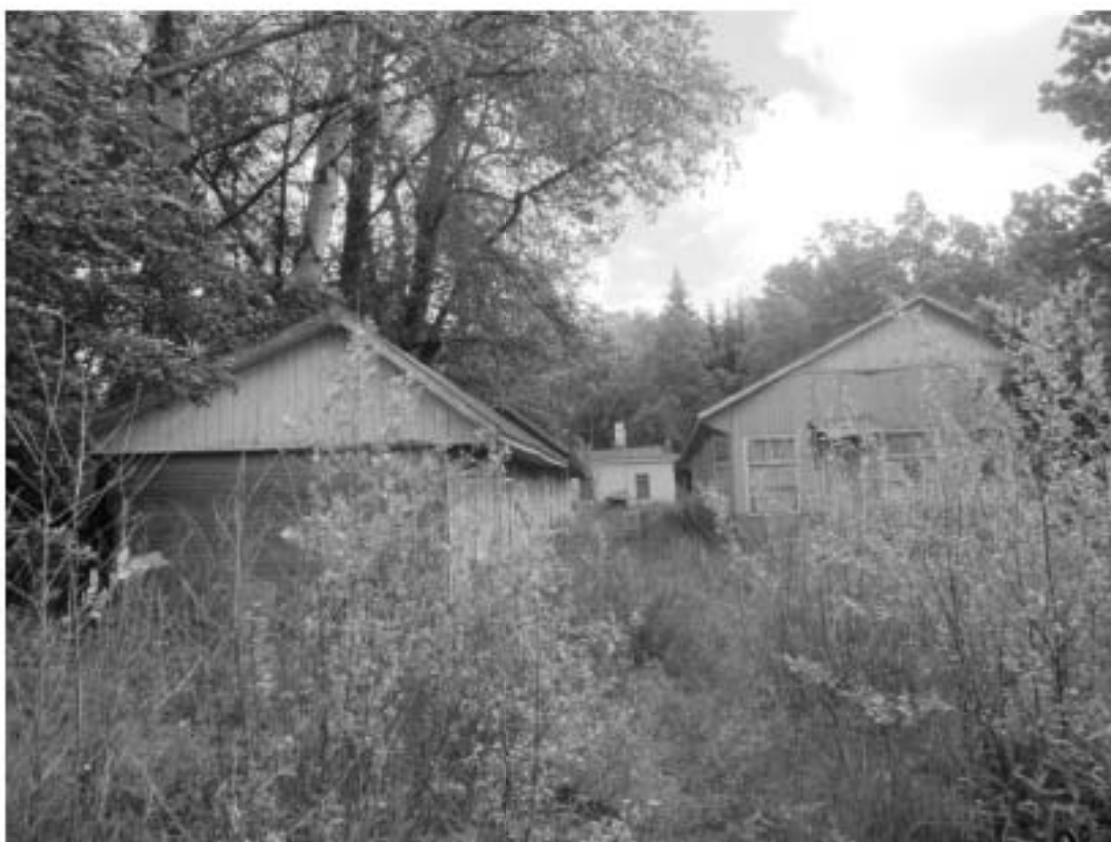
6. Северная часть территории ОКН «Загородный дом Ф.Р. Витцеля». Здания по адресу: Санкт-Петербург, г. Сестрорецк, Парковая ул., д. 14, лит. И; Парковая ул., д. 14, лит. П. Дата съемки: 01.08.2017 г.
