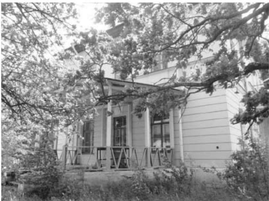
14. Вид на ОКН «Загородный дом Ф.Р. Витцеля» по адресу: Санкт-Петербург, г. Сестрорецк, Парковая ул., д. 14 литера А. Северный фасад. Дата съемки: 01.08.2017 г.
