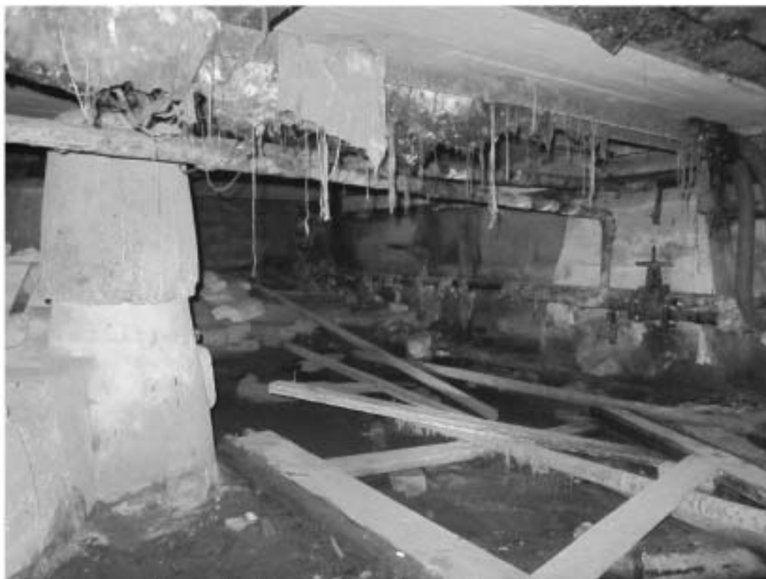
94. «Загородный дом Ф.Р. Витцеля» по адресу: Санкт-Петербург, г. Сестрорецк, Парковая ул., дом 14, литера А. Техническое подполье. Дата съемки: 01.08.2017 г.
