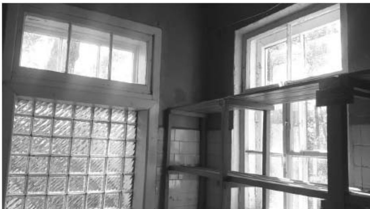
83. «Загородный дом Ф.Р. Витцеля» по адресу: Санкт-Петербург, г. Сестрорецк, Парковая ул., дом 14, литера А. Одноэтажная пристройка. Помещение №4 (12,7). Дата съемки: 01.08.2017 г.
