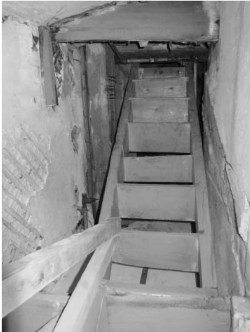
87. «Загородный дом Ф.Р. Витцеля» по адресу: Санкт-Петербург, г. Сестрорецк, Парковая ул., дом 14, литера А. Деревянная лестница (помещение №15), ведущая на чердак. Дата съемки: 01.08.2017 г.
