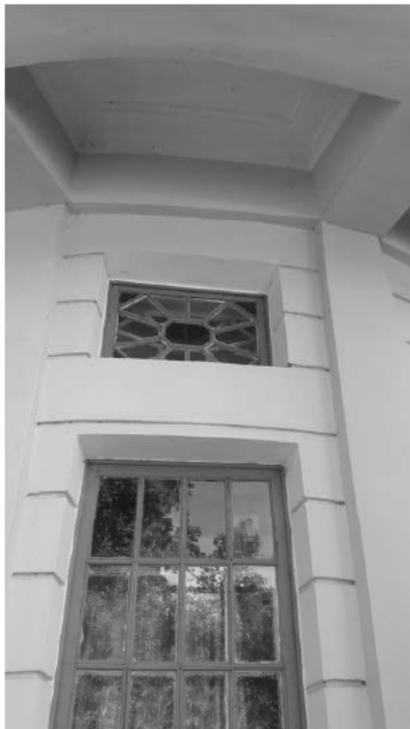
10. «Загородный дом Ф.Р. Витцеля» по адресу: Санкт-Петербург, г. Сестрорецк, Парковая ул., д. 14, литера А. Восточный фасад. Оконный проем в уровне 1-го этажа. Дата съемки: 01.08.2017 г.
