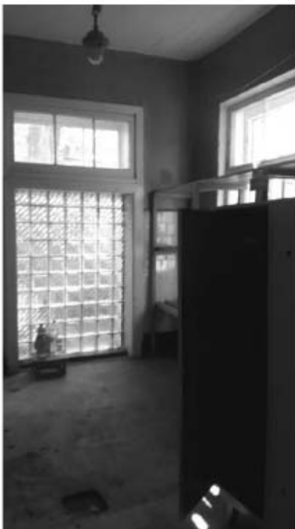
82. «Загородный дом Ф.Р. Витцеля» по адресу: Санкт-Петербург, г. Сестрорецк, Парковая ул., дом 14, литера А. Одноэтажная пристройка. Помещение №4 (12,7). Дата съемки: 01.08.2017 г.
