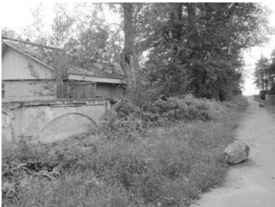
27. Северная граница территории ОКН «Загородный дом Ф.Р. Витцеля». Здание по адресу: Санкт-Петербург, г. Сестрорецк, Парковая ул., д. 14, лит. И. Фрагмент каменной ограды вдоль Садовой улицы. Дата съемки: 01.08.2017 г.
