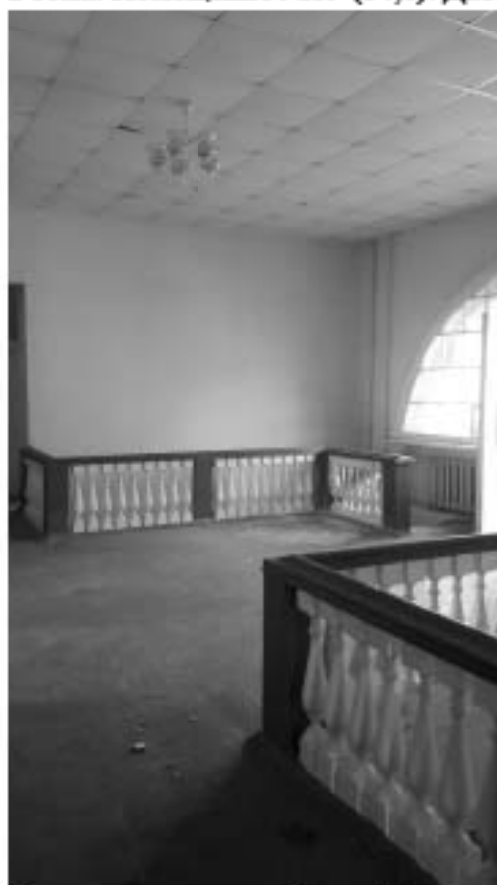
59. «Загородный дом Ф.Р. Витцеля» по адресу: Санкт-Петербург, г. Сестрорецк, Парковая ул., дом 14, литера А. 2 этаж. Помещение №13 (33,0) Вестибюль. Дата съемки: 01.08.2017 г.
