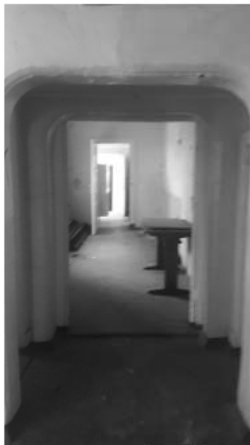
25. «Загородный дом Ф.Р. Витцеля» по адресу: Санкт-Петербург, г. Сестрорецк, Парковая ул., дом 14, литера А. 1 этаж. Помещение №9 (13,7) Коридор. Дата съемки: 01.08.2017 г.
