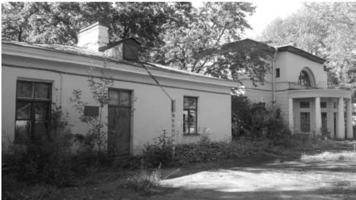
1. «Загородный дом Ф.Р. Витцеля» по адресу: Санкт-Петербург, г. Сестрорецк, Парковая ул., д. 14, литера А. Восточный фасад. Фрагмент. Дата съемки: 01.08.2017 г.
