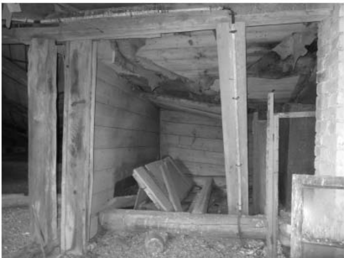
93. «Загородный дом Ф.Р. Витцеля» по адресу: Санкт-Петербург, г. Сестрорецк, Парковая ул., дом 14, литера А. Чердак. Дата съемки: 01.08.2017 г.
