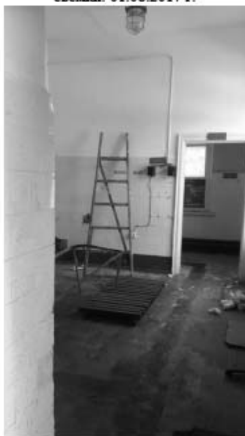
74. «Загородный дом Ф.Р. Витцеля» по адресу: Санкт-Петербург, г. Сестрорецк, Парковая ул., дом 14, литера А. Одноэтажная пристройка. Помещение №6 (13,5). Дата съемки: 01.08.2017 г.
