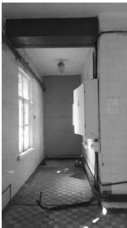
80. «Загородный дом Ф.Р. Витцеля» по адресу: Санкт-Петербург, г. Сестрорецк, Парковая ул., дом 14, литера А. Одноэтажная пристройка. Помещение №5 (33,1). Дата съемки: 01.08.2017 г.
