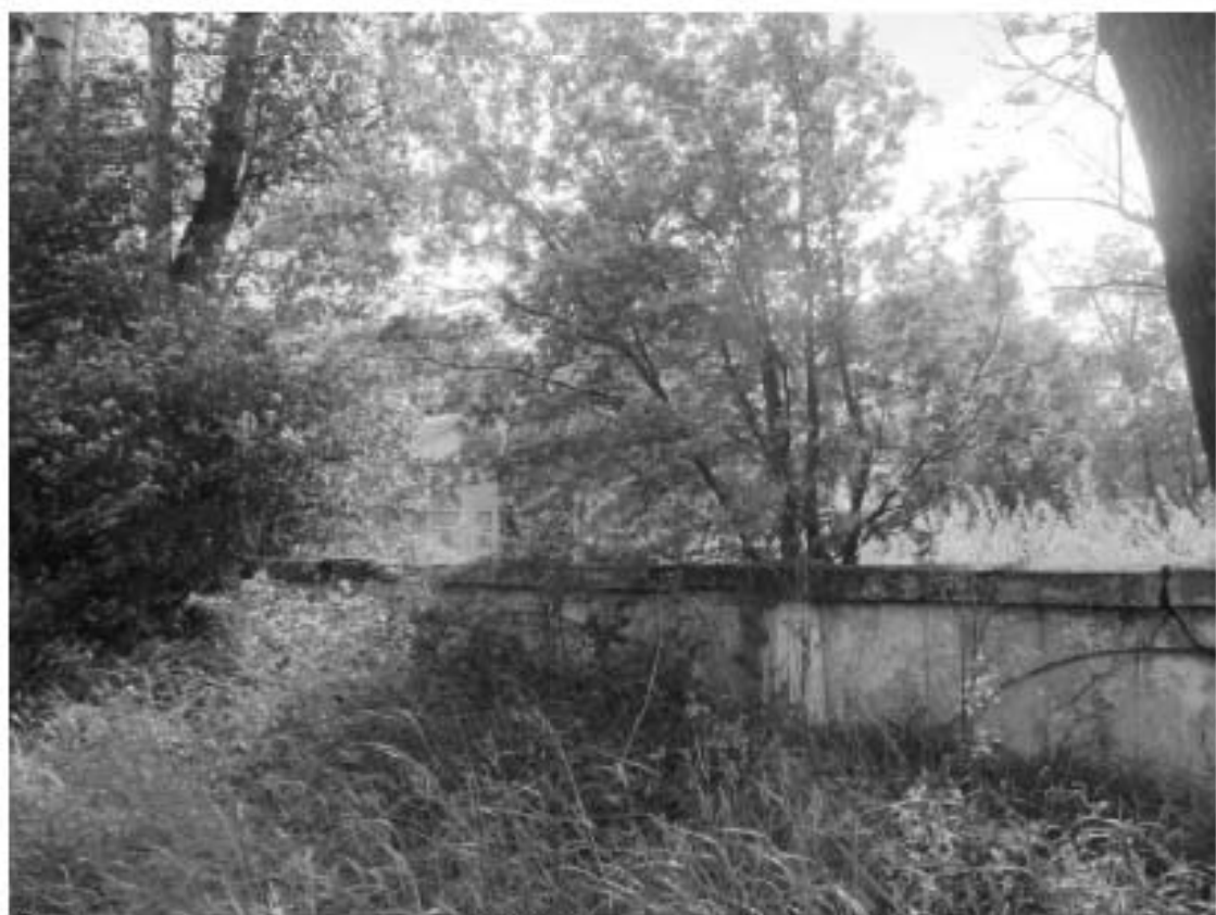
10. Северная часть территории ОКН «Загородный дом Ф.Р. Витцеля». Фрагмент ограждения вдоль Садовой улицы. Дата съемки: 01.08.2017 г.
