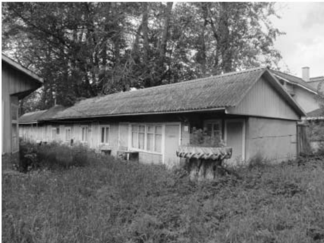
5. Северная часть территории ОКН «Загородный дом Ф.Р. Витцеля». Здание по адресу: Санкт-Петербург, г. Сестрорецк, Парковая ул., д. 14, литера И. Южный и восточный фасады. Дата съемки: 01.08.2017 г.
