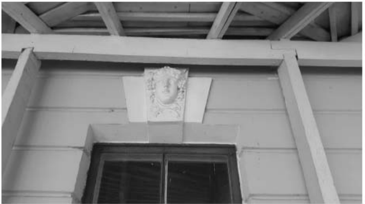
15. «Загородный дом Ф.Р. Витцеля» по адресу: Санкт-Петербург, г. Сестрорецк, Парковая ул., д. 14, литера А. Замковый камень, украшенный маскаронем. Дата съемки: 01.08.2017 г.
