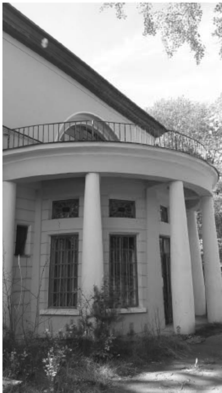
7. «Загородный дом Ф.Р. Витцеля» по адресу: Санкт-Петербург, г. Сестрорецк, Парковая ул., д. 14, литера А. Восточный фасад. Полуротонда с колоннадой, балкон в уровне 2-го этажа. Дата съемки: 01.08.2017 г.
