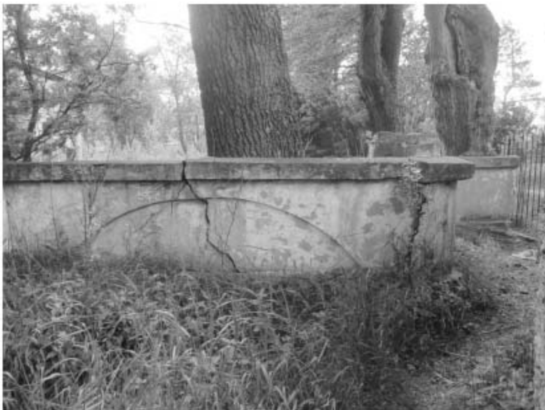
9. Северо-западная часть территории ОКН «Загородный дом Ф.Р. Витцеля». Фрагмент ограждения вдоль Садовой улицы. Дата съемки: 01.08.2017 г.
