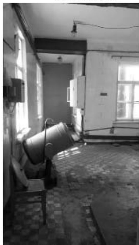
78. «Загородный дом Ф.Р. Витцеля» по адресу: Санкт-Петербург, г. Сестрорецк, Парковая ул., дом 14, литера А. Одноэтажная пристройка. Помещение №5 (33,1). Дата съемки: 01.08.2017 г.
