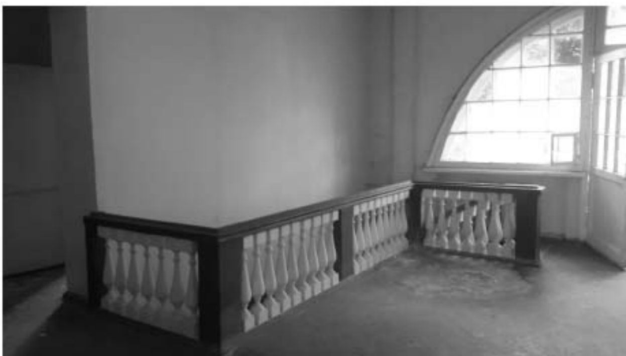
47. «Загородный дом Ф.Р. Витцеля» по адресу: Санкт-Петербург, г. Сестрорецк, Парковая ул., дом 14, литера А. 2 этаж. Помещение №13 (33,0) Вестибюль. Дата съемки: 01.08.2017 г.
