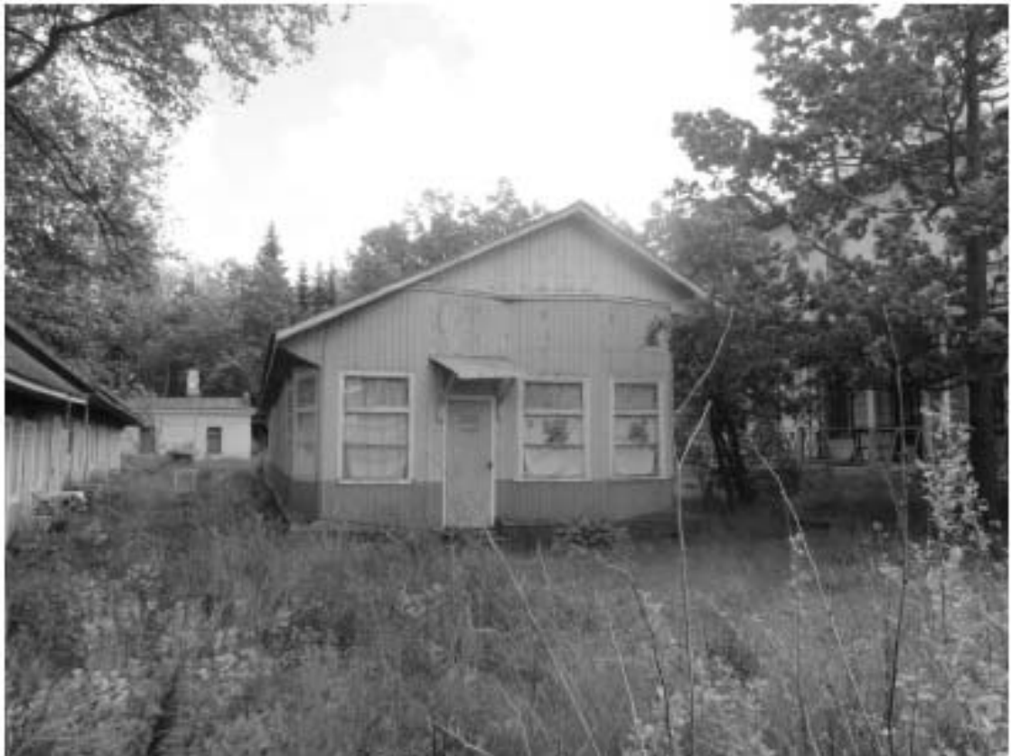
7. Северная часть территории ОКН «Загородный дом Ф.Р. Витцеля». Здание по адресу: Санкт-Петербург, г. Сестрорецк, Парковая ул., д. 14, литера П. Западный фасад. Дата съемки: 01.08.2017 г.
