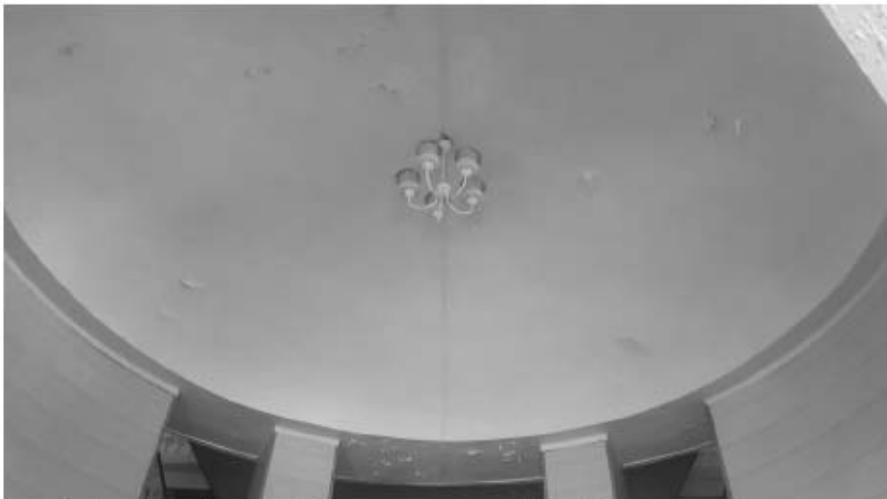
4. «Загородный дом Ф.Р. Витцеля» по адресу: Санкт-Петербург, г. Сестрорецк, Парковая ул., дом 14, литера А. Помещение №1 (35,4) Вестибюль. Дата съемки: 01.08.2017 г.
