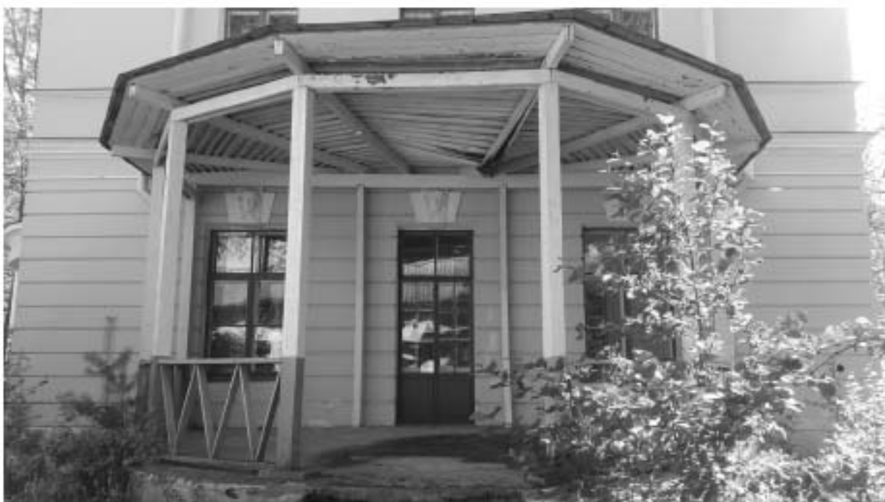
13. «Загородный дом Ф.Р. Витцеля» по адресу: Санкт-Петербург, г. Сестрорецк, Парковая ул., д. 14, литера А. Открытая терраса-полуротонда. Дата съемки: 01.08.2017 г.
