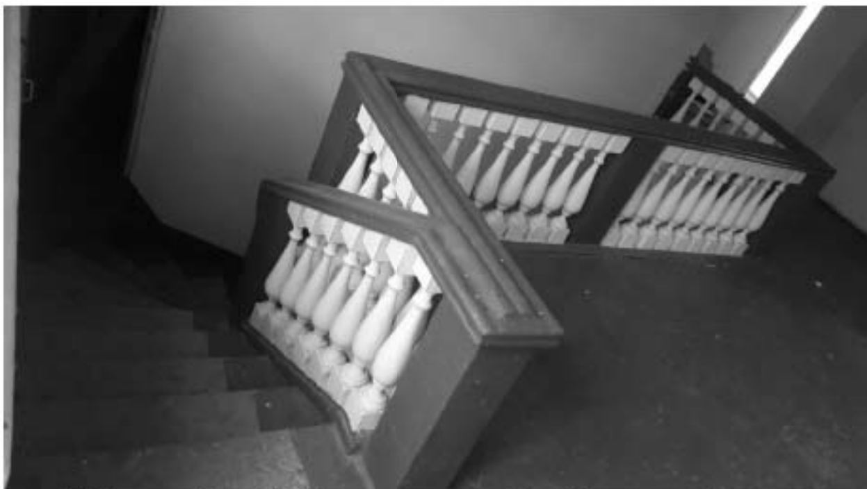
46. «Загородный дом Ф.Р. Витцеля» по адресу: Санкт-Петербург, г. Сестрорецк, Парковая ул., дом 14, литера А. 2 этаж. Помещение №28 (9,8) Лестница. Дата съемки: 01.08.2017 г.
