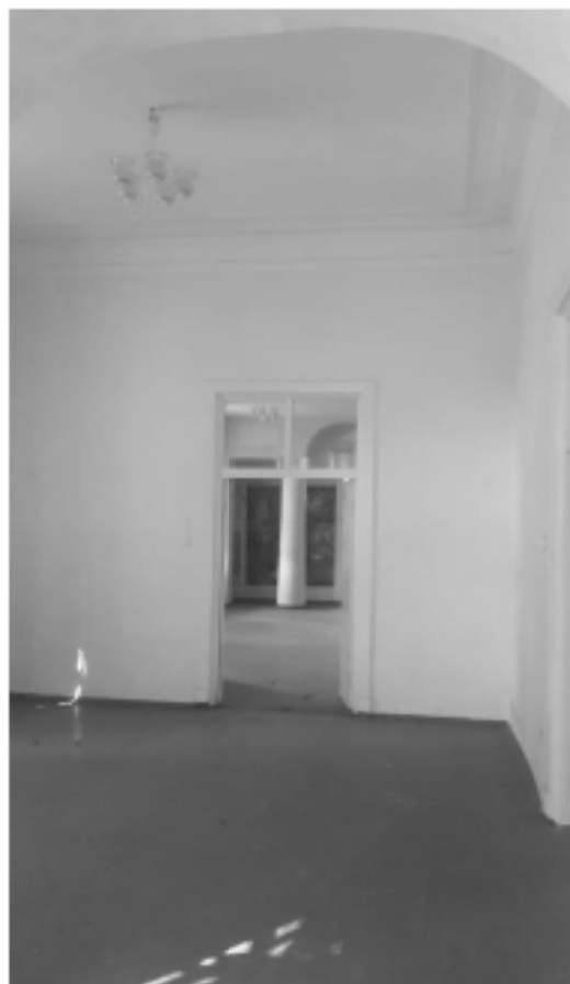
35. «Загородный дом Ф.Р. Витцеля» по адресу: Санкт-Петербург, г. Сестрорецк, Парковая ул., дом 14, литера А. 1 этаж. Помещение №6 (20,8). Дата съемки: 01.08.2017 г.
