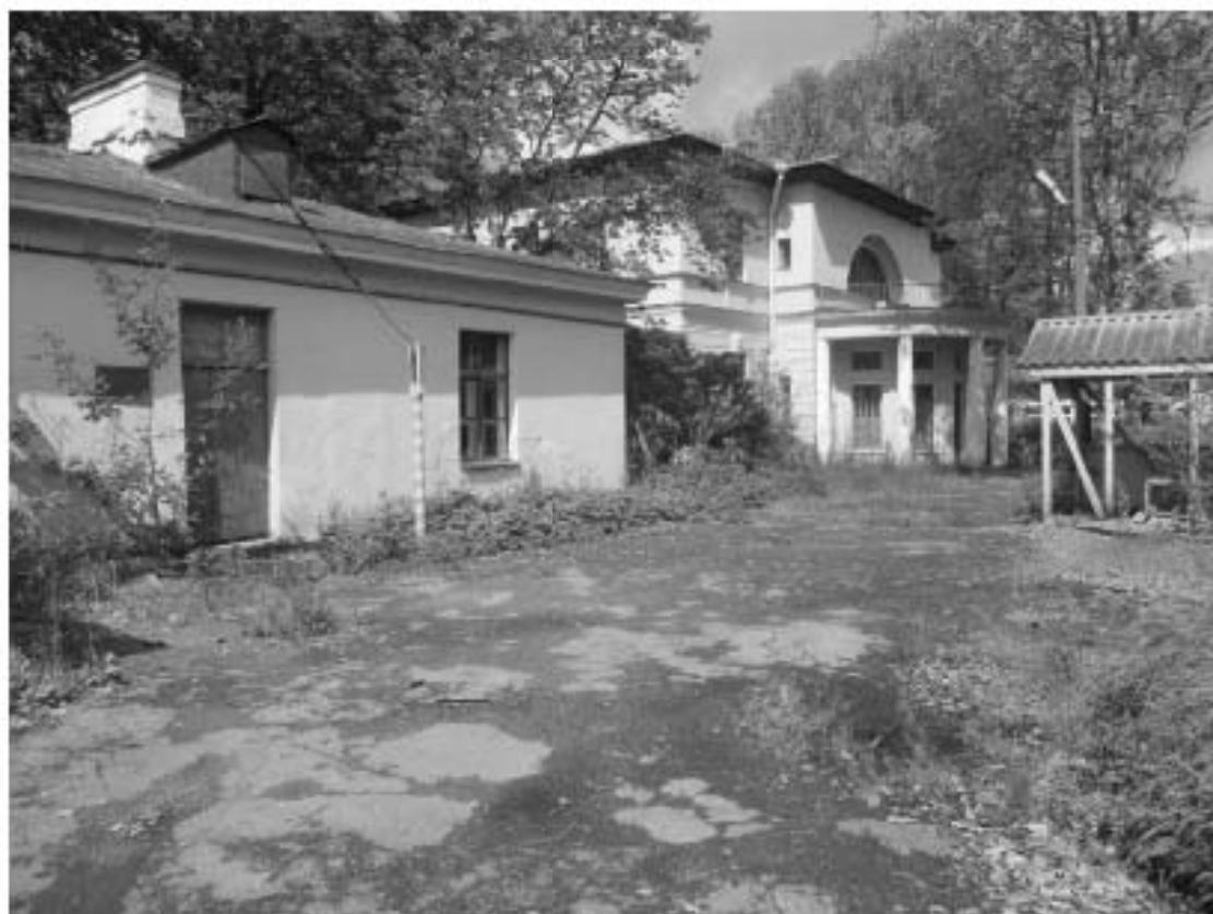
19. Вид на южную часть территории и восточный фасад ОКН «Загородный дом Ф.Р. Витцеля» по адресу: Санкт-Петербург, г. Сестрорецк, Парковая ул., д. 14 литера А. Дата съемки: 01.08.2017 г.
