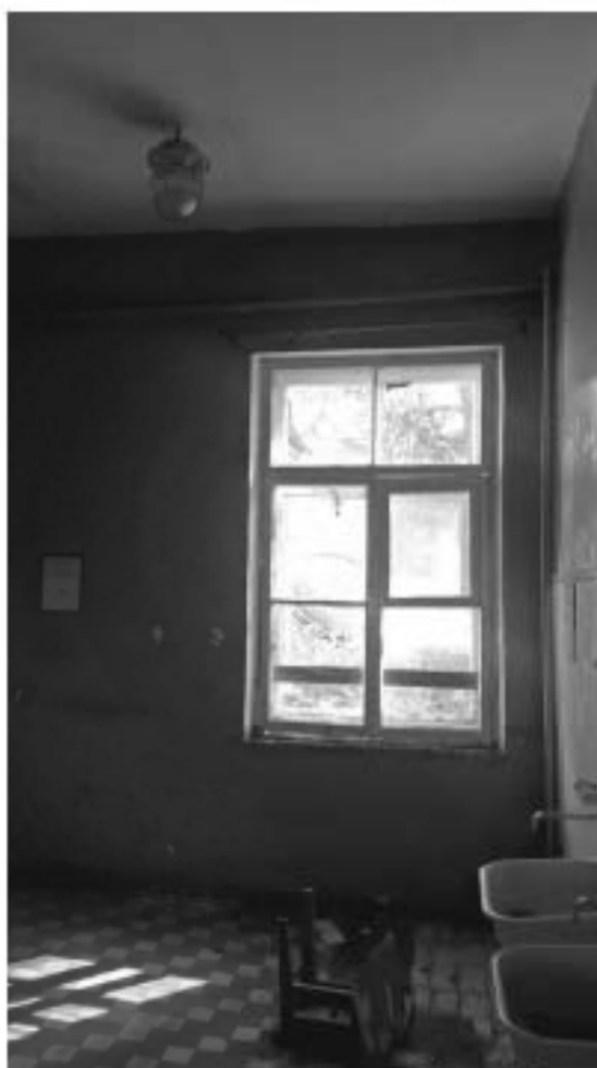
84. «Загородный дом Ф.Р. Витцеля» по адресу: Санкт-Петербург, г. Сестрорецк, Парковая ул., дом 14, литера А. Одноэтажная пристройка. Помещение №3 (13,5). Дата съемки: 01.08.2017 г.
