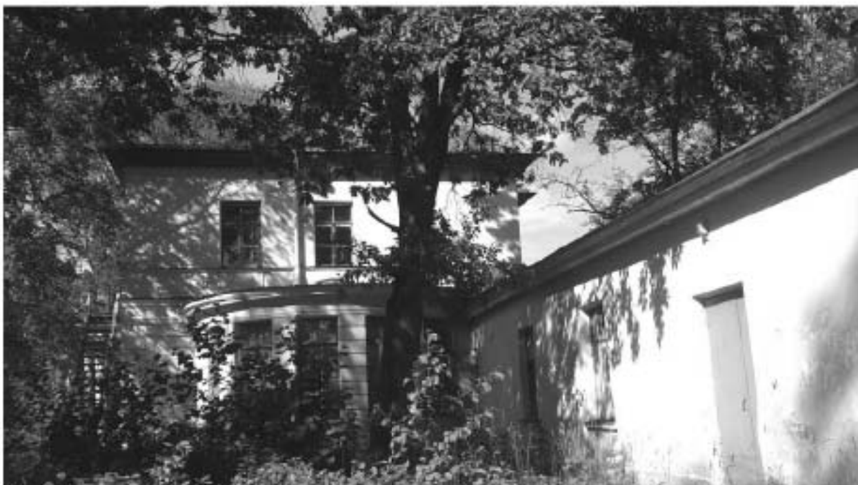
23. «Загородный дом Ф.Р. Витцеля» по адресу: Санкт-Петербург, г. Сестрорецк, Парковая ул., д. 14, литера А. Южный фасад. Дата съемки: 01.08.2017 г.
