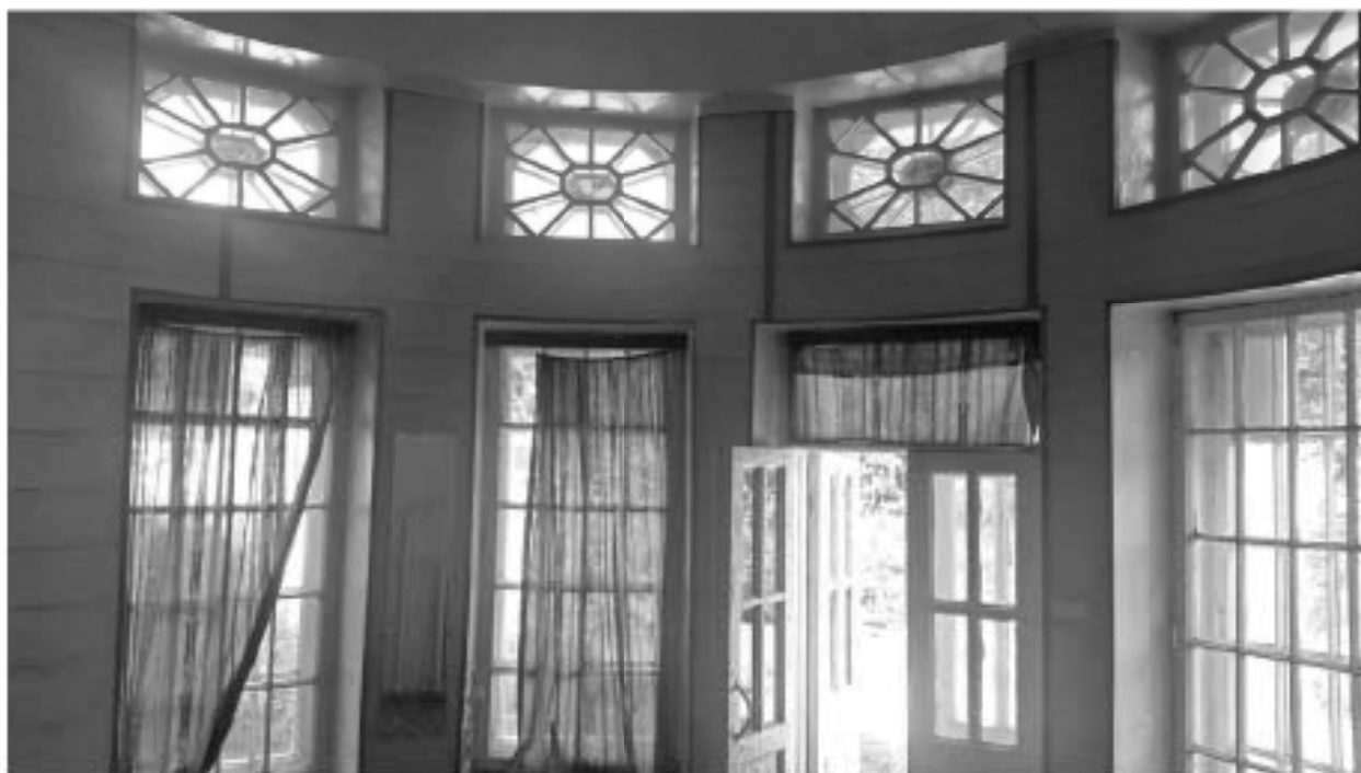
1. «Загородный дом Ф.Р. Витцеля» по адресу: Санкт-Петербург, г. Сестрорецк, Парковая ул., дом 14, литера А. 1 этаж. Помещение №1 (35,4) Вестибюль. Дата съемки: 01.08.2017 г.
