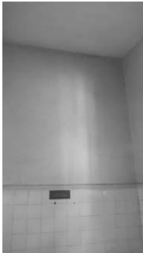
76. «Загородный дом Ф.Р. Витцеля» по адресу: Санкт-Петербург, г. Сестрорецк, Парковая ул., дом 14, литера А. Одноэтажная пристройка. Помещение №7 (6,2). Дата съемки: 01.08.2017 г.
