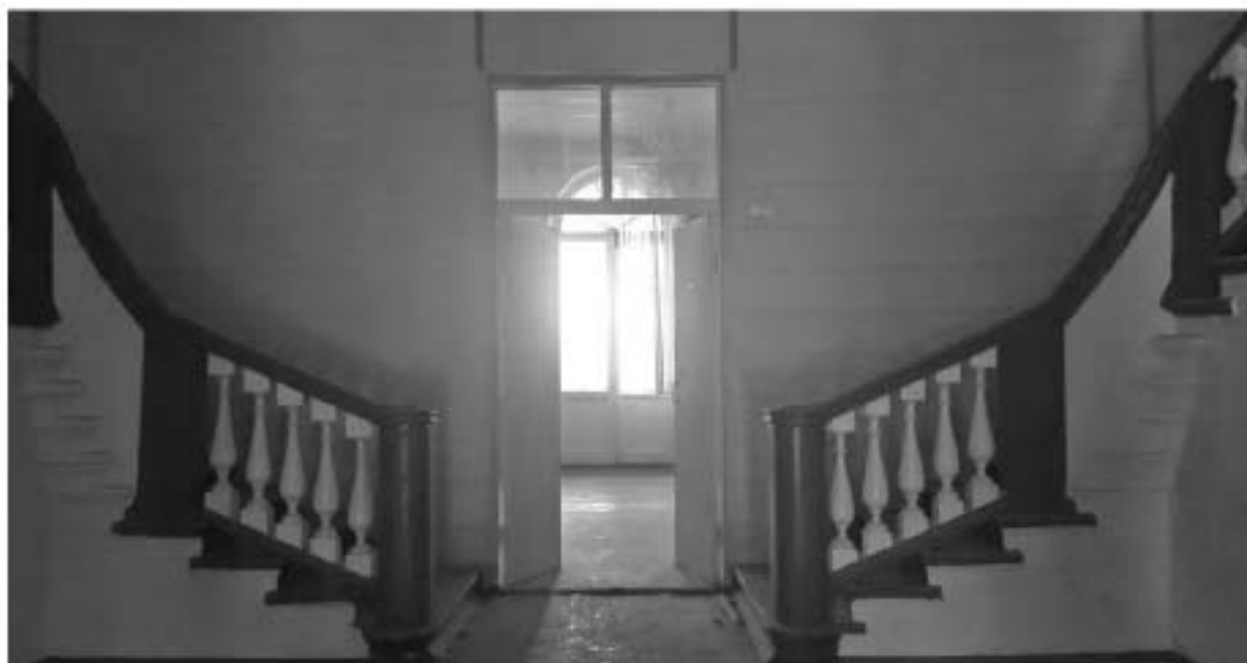
5. «Загородный дом Ф.Р. Витцеля» по адресу: Санкт-Петербург, г. Сестрорецк, Парковая ул., дом 14, литера А. 1 этаж. Помещение №1 (35,4) Вестибюль. Дата съемки: 01.08.2017 г.
